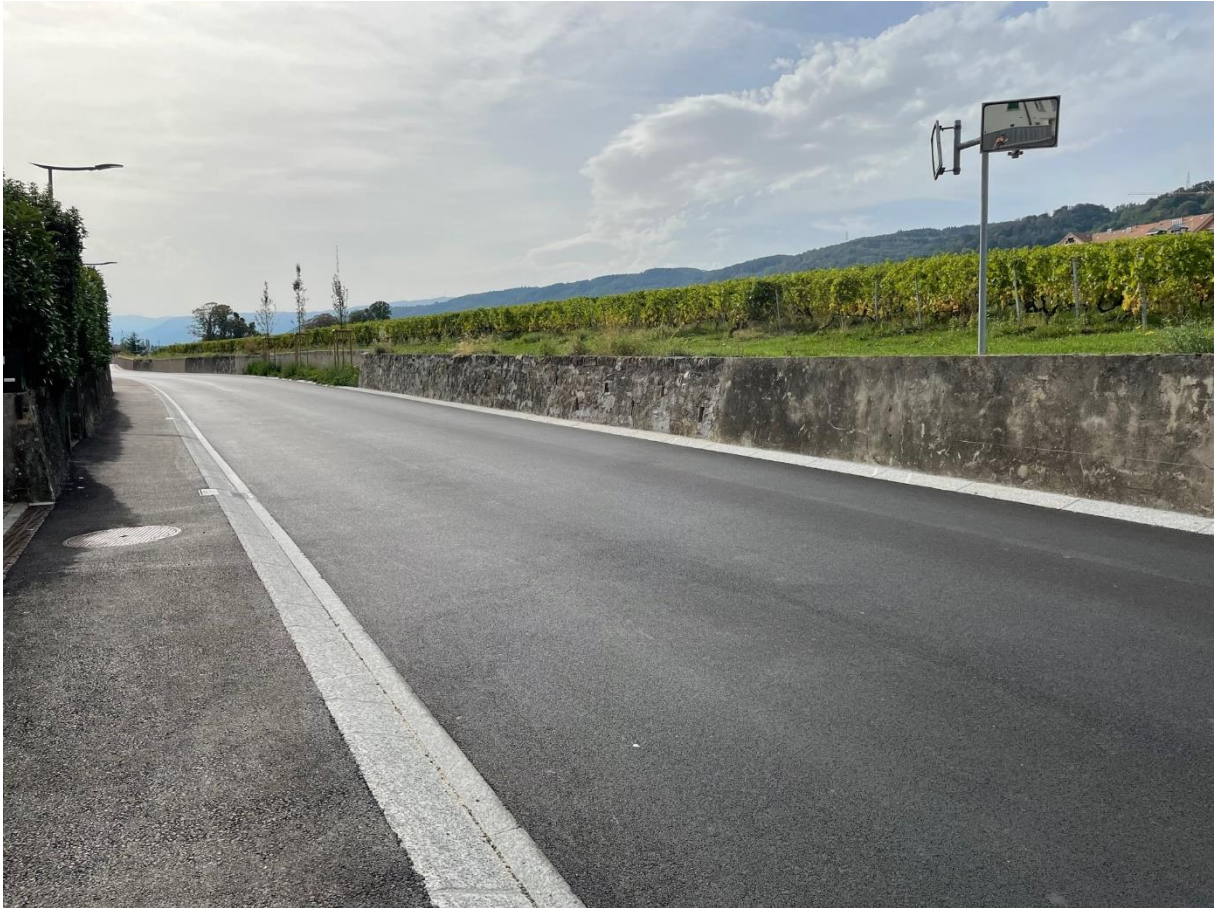
Route de l'Etraz : tronçon Mont-sur-Rolle
