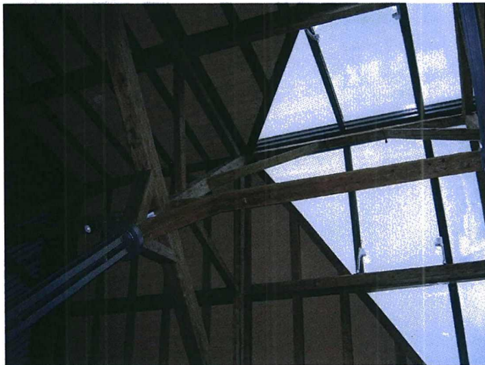
Appui statique de la verrière bois-métal
