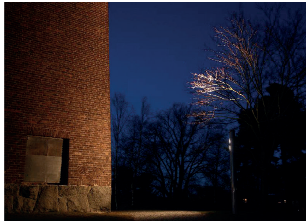
Le sol éclaire la façade
