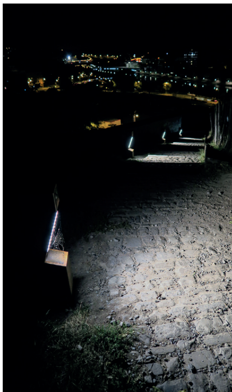
éclairage rasant fonctionnel pour laisser apprécier le panorama. Citadelle de Namur / Radiance 35
