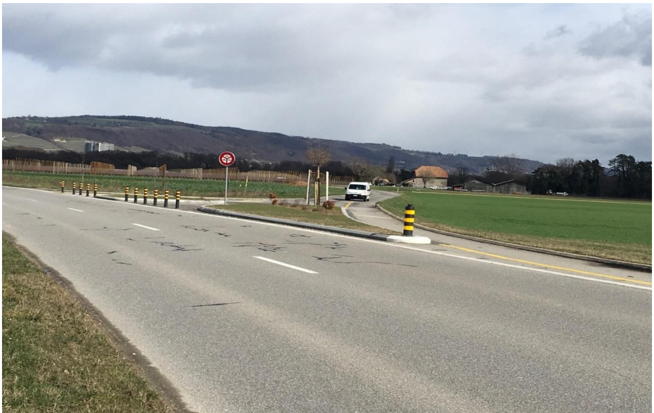
Nouveaux aménagements au carrefour de la route de l'Etraz et de la route de Gland
