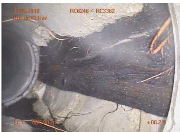
Réparation effectuée avec une planche en bois
