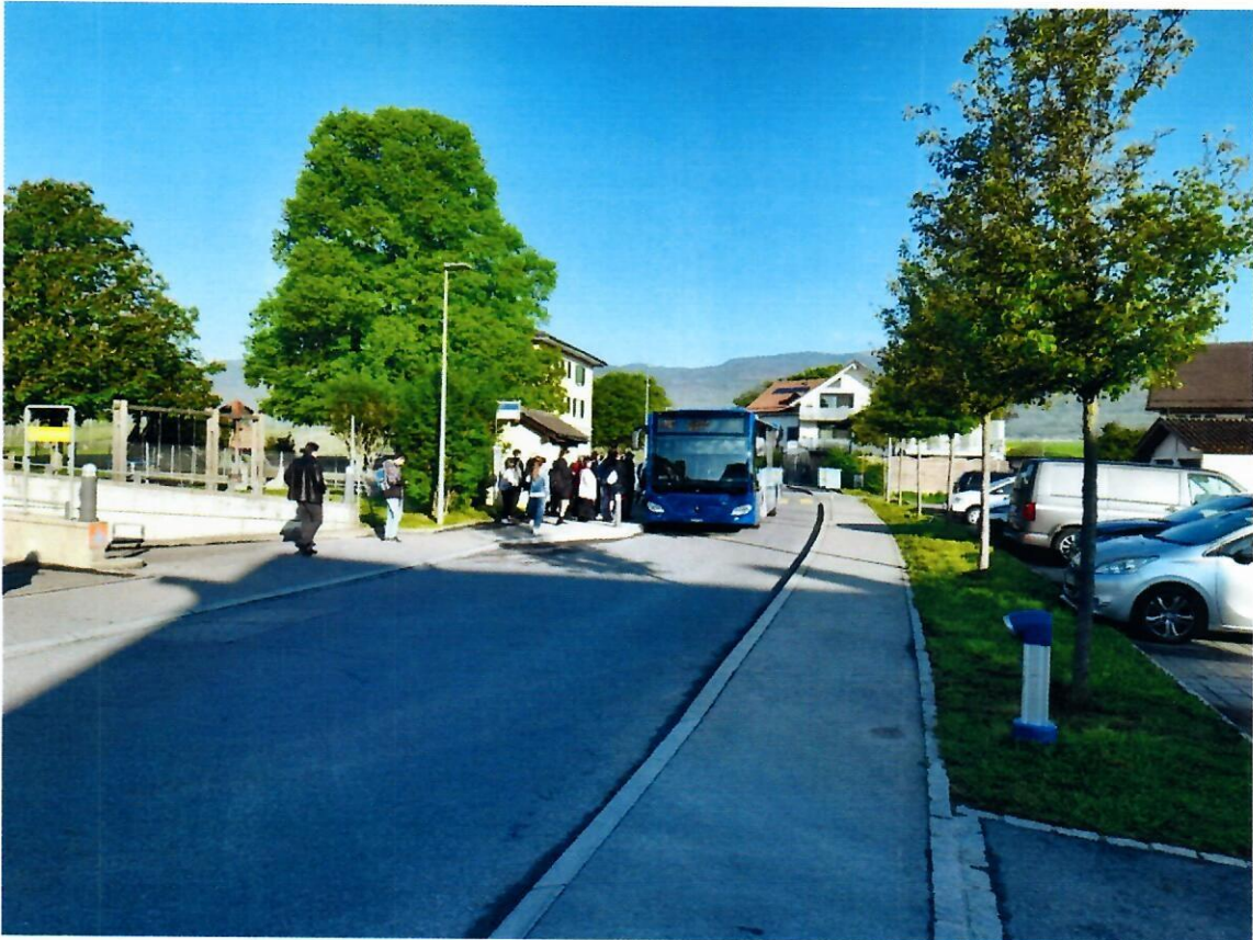
Exemple de rétrécissement de chaussée au chemin du Vieux Collège à Eysins et partagé par la municipalité.
