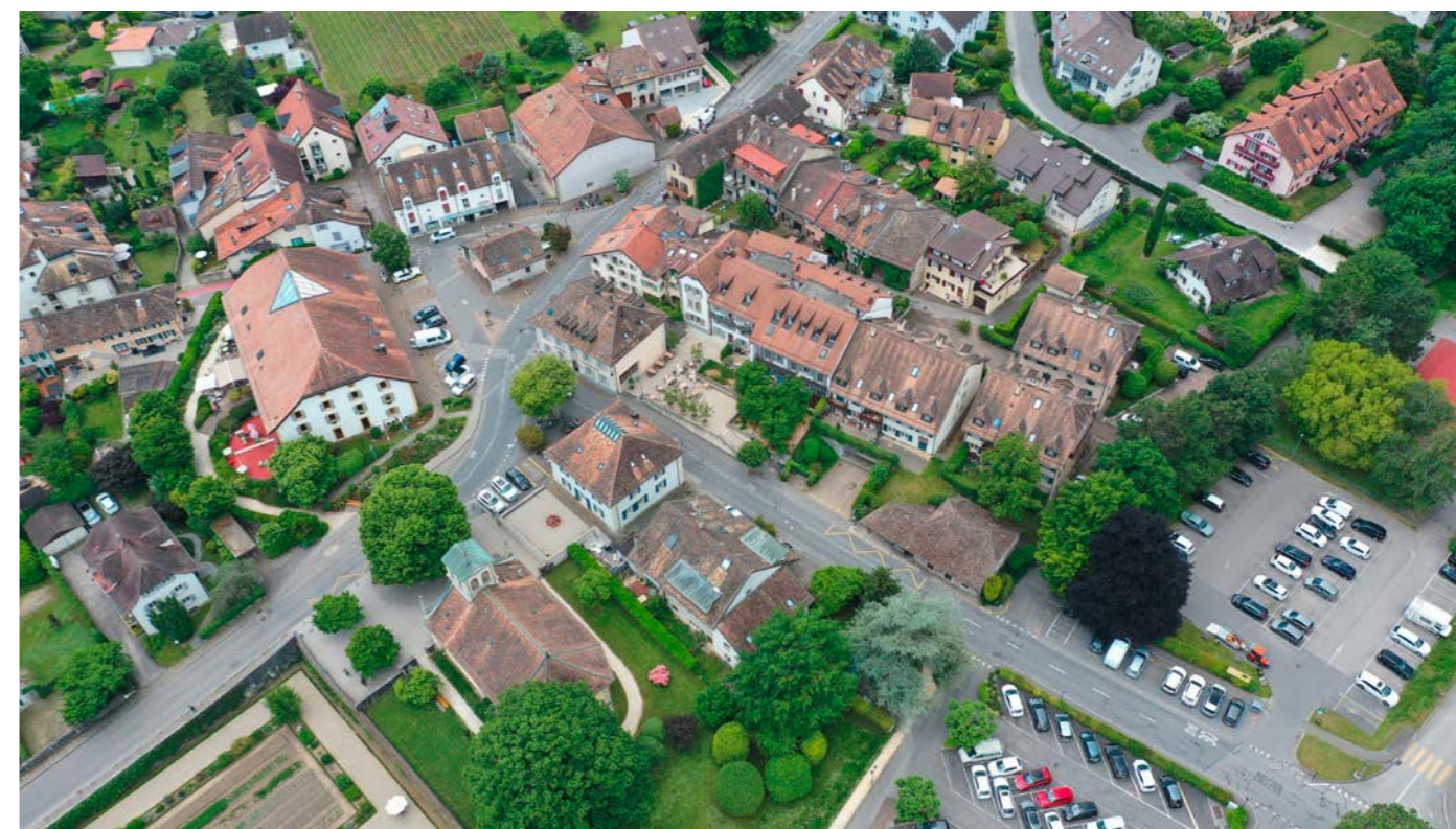
Au centre du village : la planification énergétique projette un éventuel chauffage à distance.
