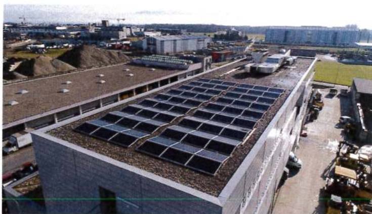
Exemple d'installation photovoltaïque ajoutée sur un bâtiment administratif à Gland.
