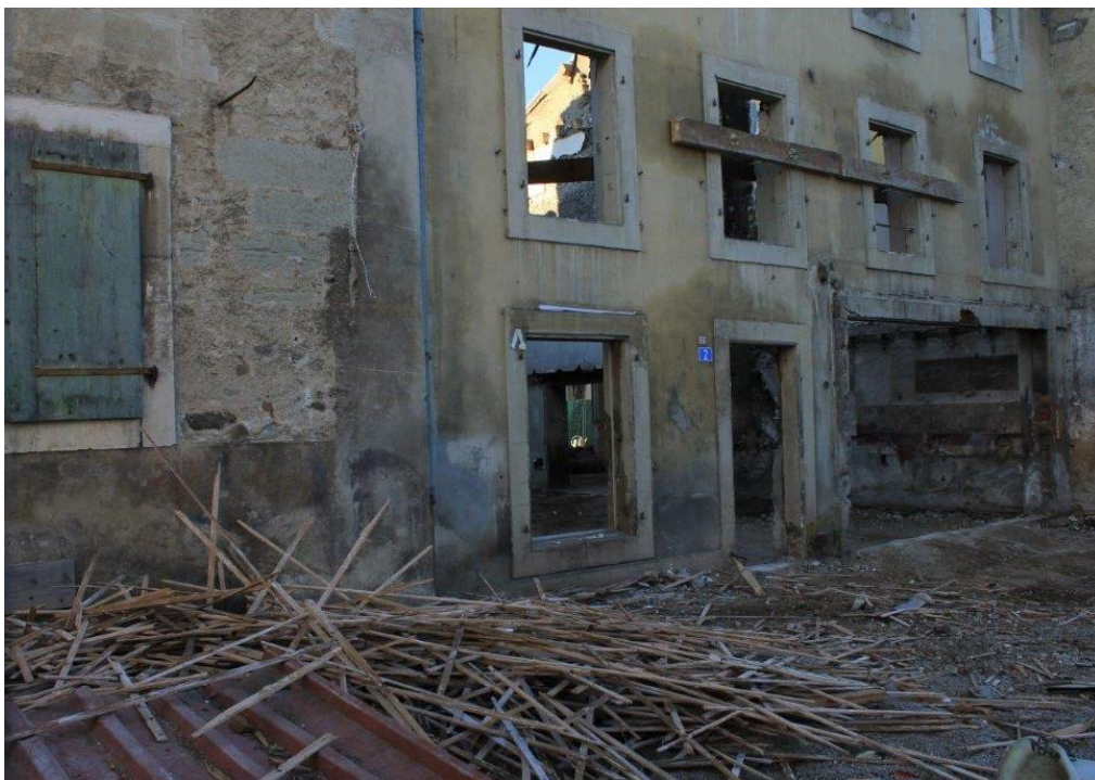
Chantier des trois Bâtiments
