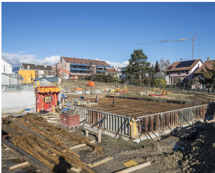
Chantier de l'école enfantine/UAPE
