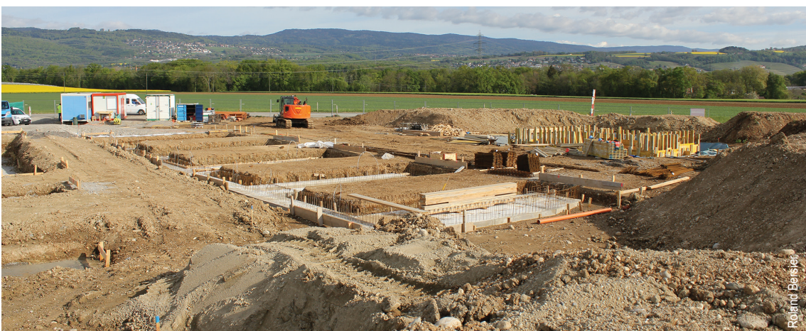
Début du chantier de construction. L'ouverture de la déchetterie est estimée au courant du mois de novembre 2015.
