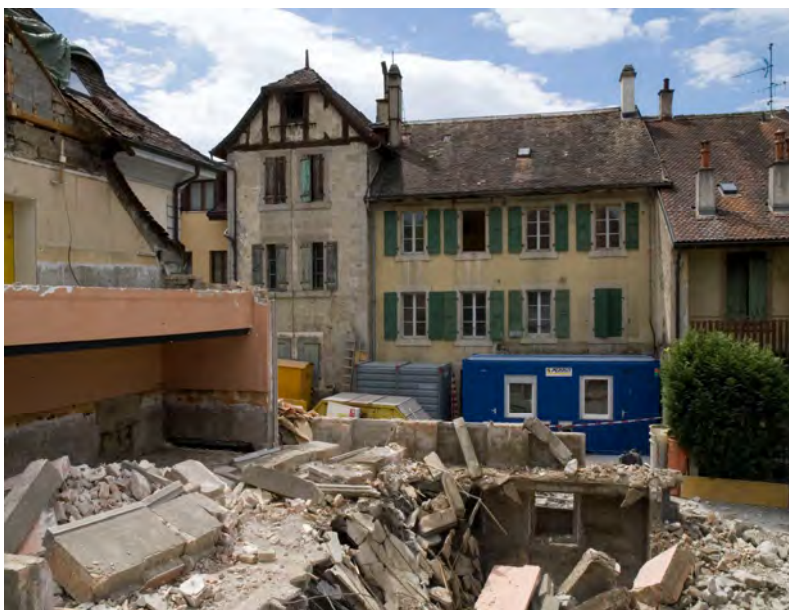
Ouverture sur les bâtiments existants ↓
