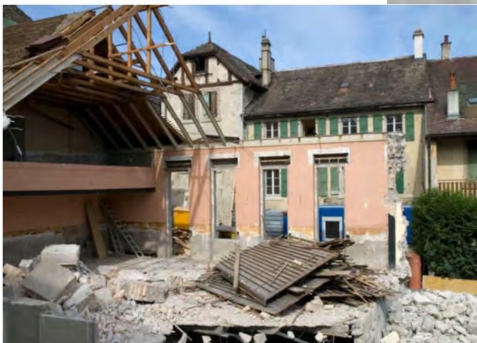
Démolition de la charpente ↓
