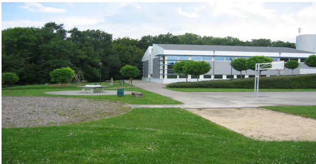
Vue de la parcelle depuis le terrain de basket
