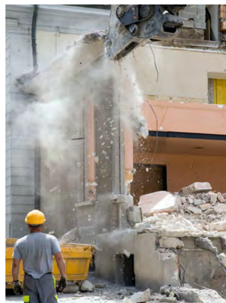
Ambiance de chantier ↓
