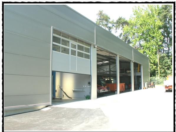
Le reste du bâtiment est réalisé par une construction simple et économique, tout en répondant aux caractéristiques techniques nécessaires à ce type d'ouvrage. La partie hall est destinée aux véhicules avec trois grandes portes industrielles et une galerie pour le dépôt de matériel. La structure métallique "poteaux-poutres" offre une grande liberté d'usage. Les façades, avec bardage en panneaux sandwich métalliques, ont un aspect sobre et discret.
