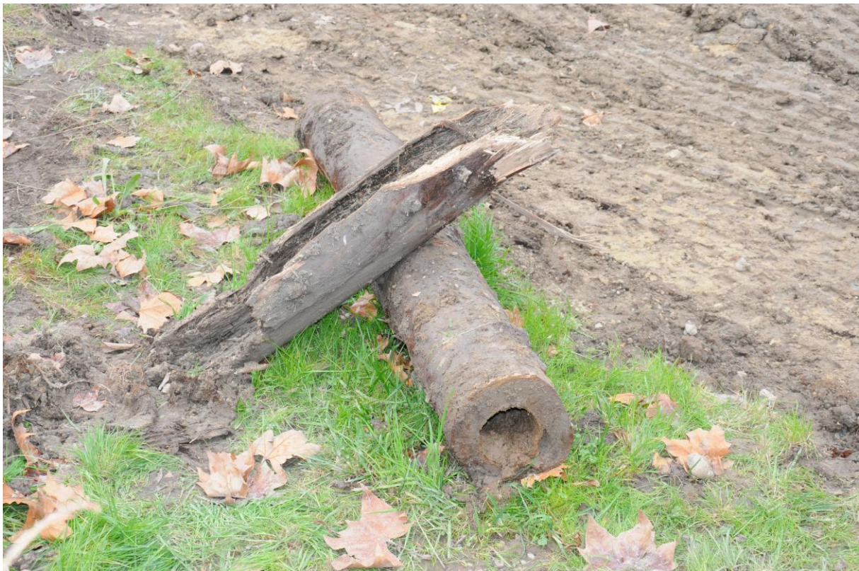
Photo 6 Tronçon de l'ancienne conduite en bois
