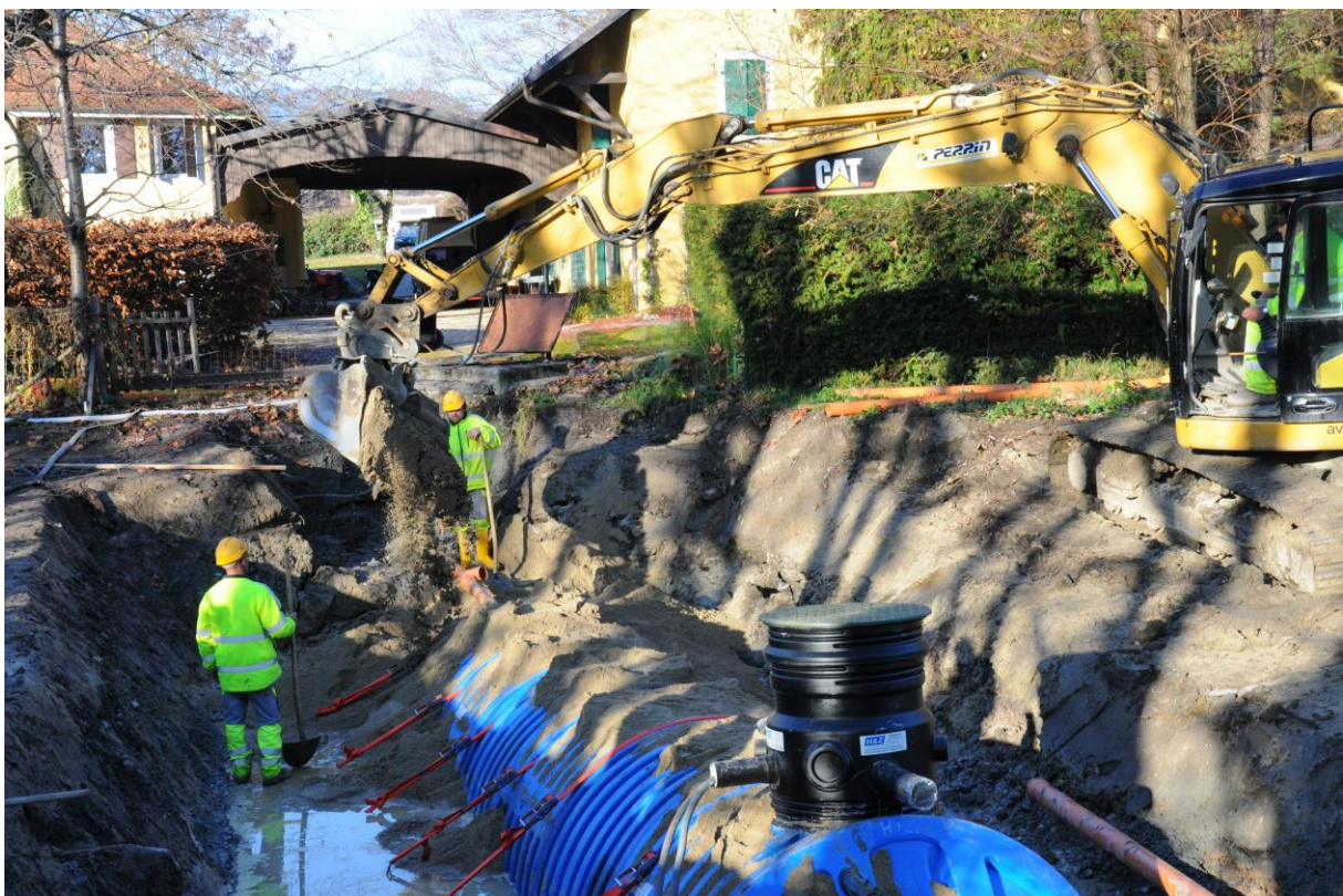
Photo 4 (11.12.2009) ... et le réservoir est fixé par les courroies. Comblement de la fosse.
