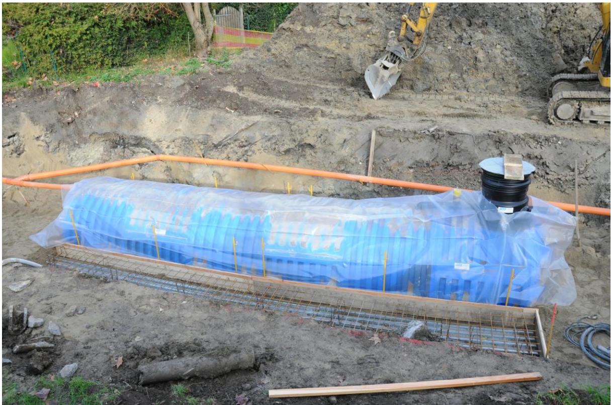
Photo 2 (10.12.2009) Les armatures métalliques des dalles sont prêtes pour la coulée du béton
