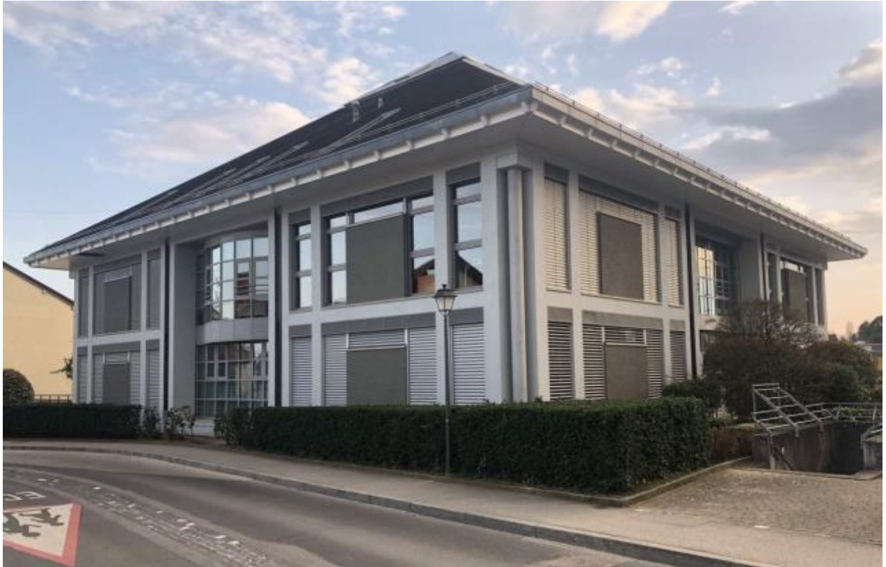
Figure 2. Vue d'ensemble de la façade du bâtiment et de son architecture spécifique
