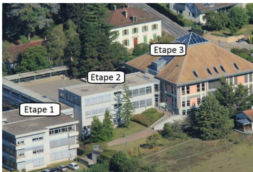
Figure 1. Bâtiment Combe 1 – Les trois étapes de constructions
